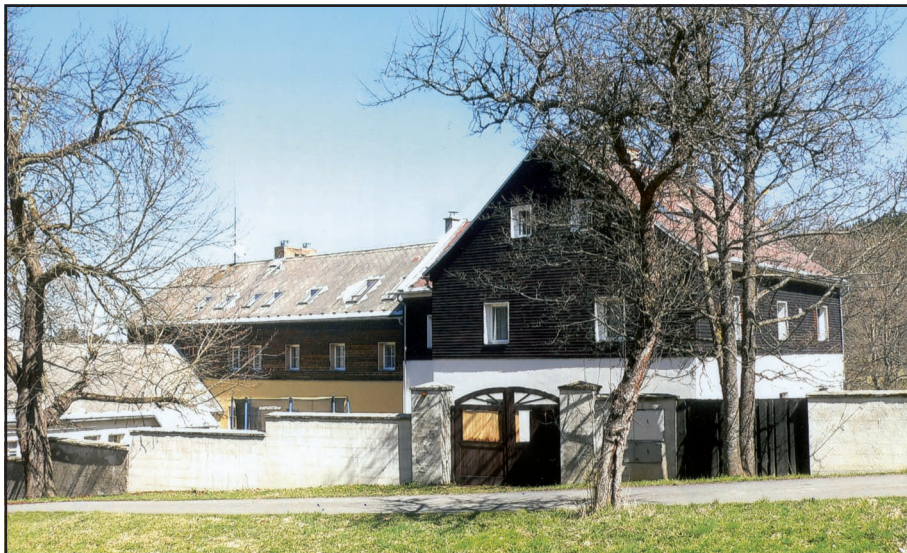
Obr. 2. Včelná pod Boubínem, místní část Pila. Budova bývalé schwarzenberské myslivny, v níž se narodil spisovatel Karel Čada – Šarlih.
