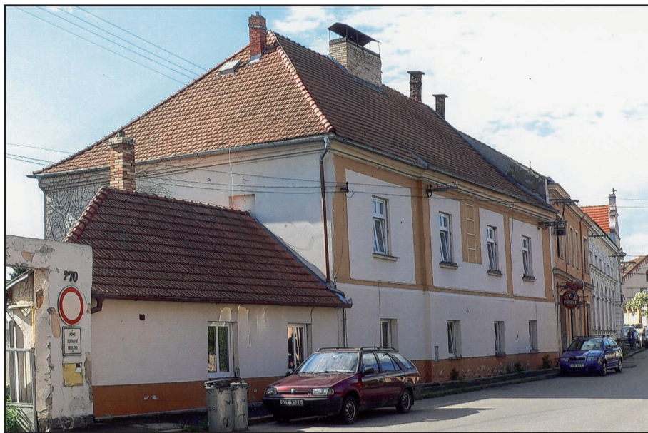
Obr. 9. Vodňany. Tyršova ulice čp. 270/II, dříve čp. 47.
